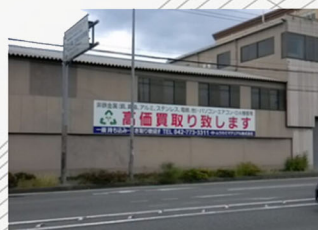
サイン製作 壁面看板
